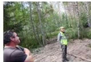
Jari Mussaari täytti vanhan ojan maa-aineksilla. Jarkko Leka arvelee, että vuoden päästä kaivuun jälkiä ei juuri näy.
